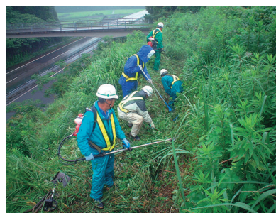
のり面小段排水溝清掃
