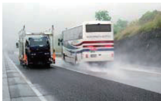
左：高機能舗装 右：従来の舗装(密粒舗装)
