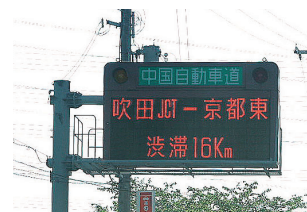
インターチェンジ入口情報板
