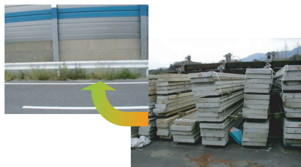
工事発生材(遮音壁)の保管状況
