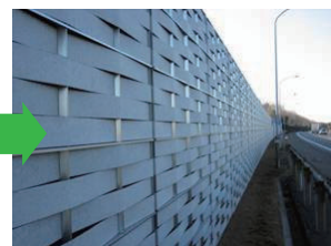
走行景観に配慮した遮音壁
