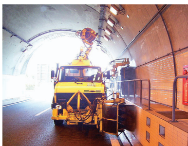
トンネル側壁清掃
