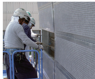
管理に配慮した遮音壁
