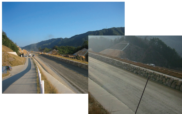
転石を中央分離帯の石積工等として再生利用 新名神高速道路（甲賀土山IC～草津田上IC）
