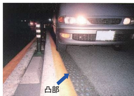
凹凸型路面標示工
