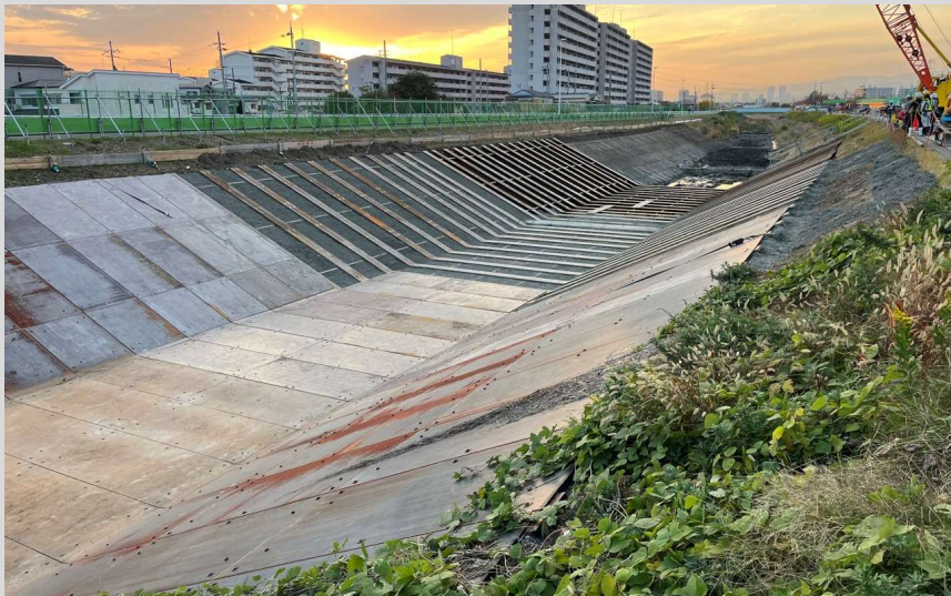
鉄樋設置状況
