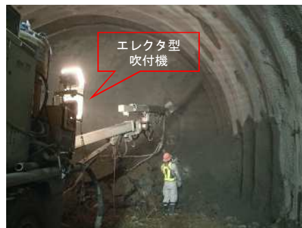
吹付コンクリート
