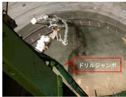
削孔（フォアポーリング）
