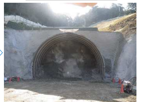
坑口切付け施工完了
