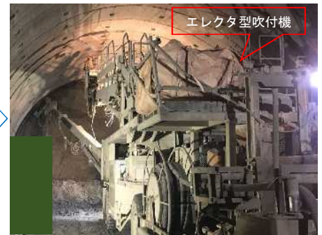
鋼アーチ支保工
