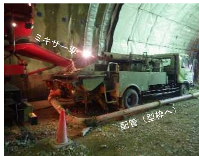
覆工コンクリート（打設）
