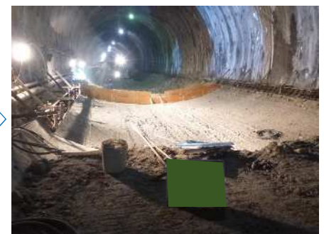
インバート型枠
