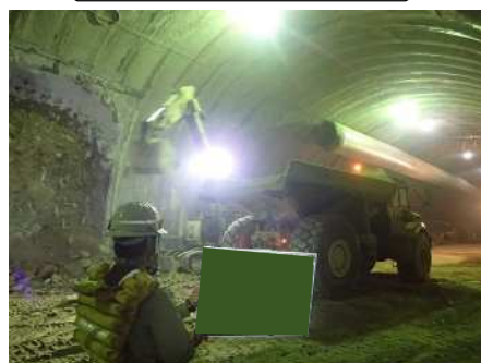
ずり処理（ずり積込み）
