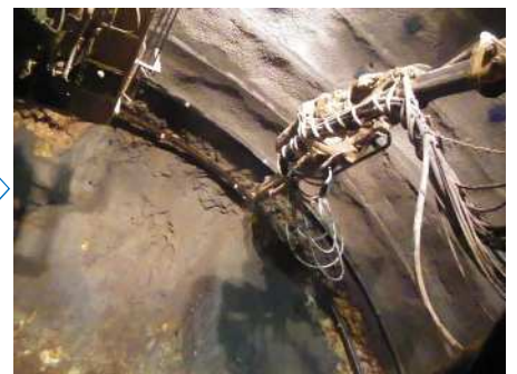
モルタル充填（フォアポーリング）
