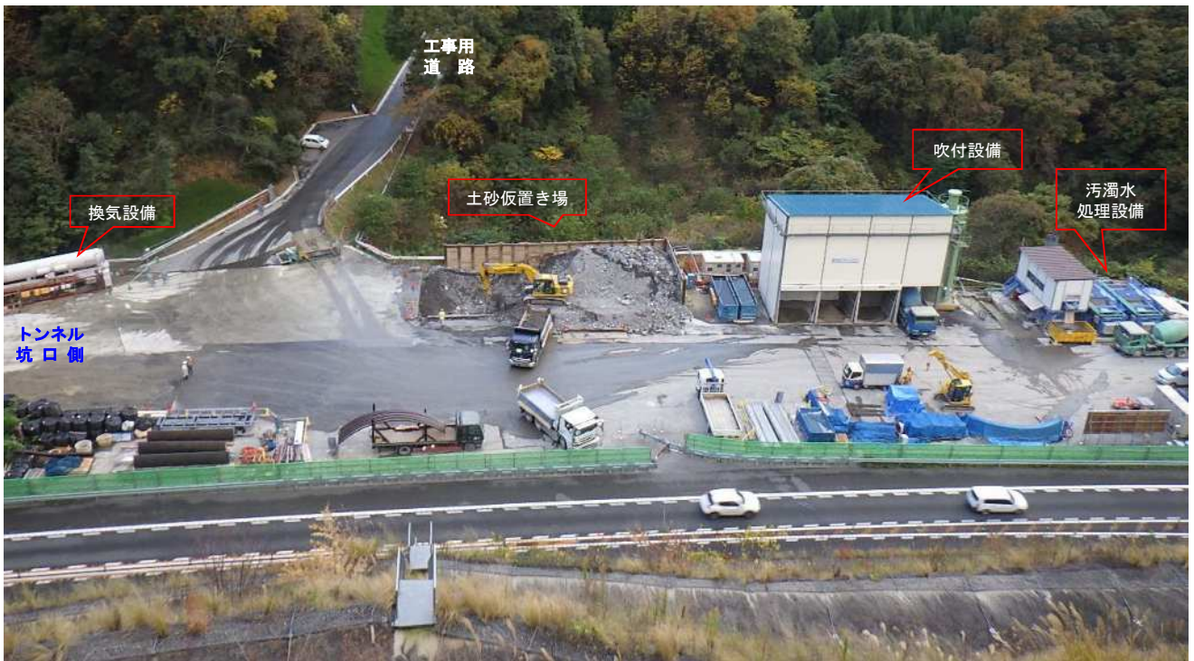
施工ヤード全景
