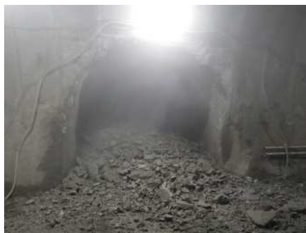
ずり処理（ずり積込み）
