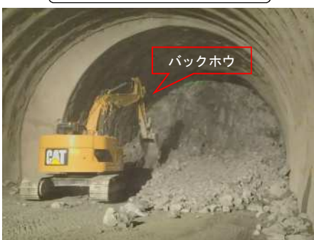
すり処理（すり積み）
