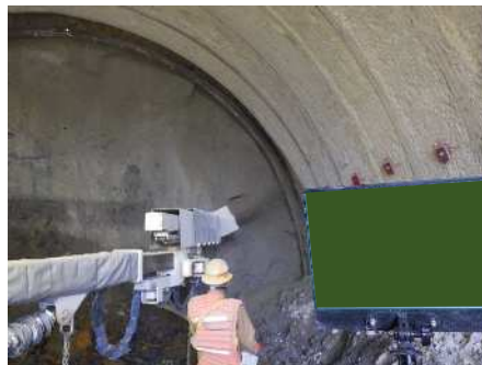
吹付コンクリート
