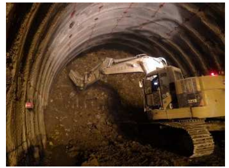
上半掘削（油圧切削機）
