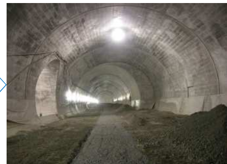
路盤排水工設置完了
