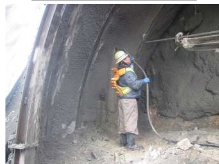
モルタル充填（ロックボルト）
