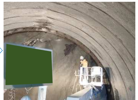
モルタル充填（フォアポーリング）
