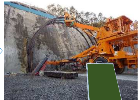
坑口切付け施工完了
