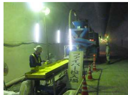
繊維現地混合（覆工コンクリート）
