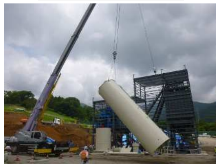
吹付設備工（搬入設置状況）
