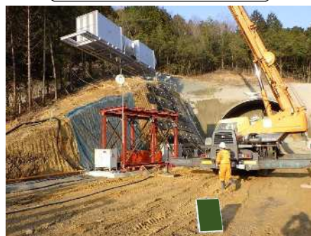
換気設備工（設置状況）
