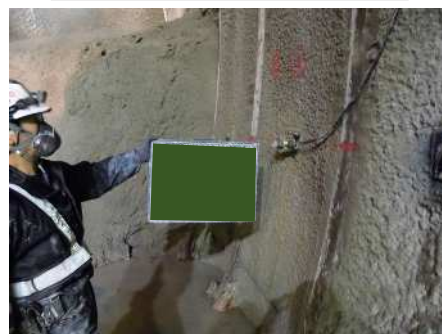
計測工B（ロックボルト軸力試験）
