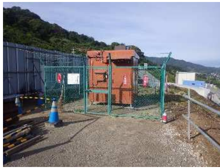
汚濁水処理工（設置状況）
