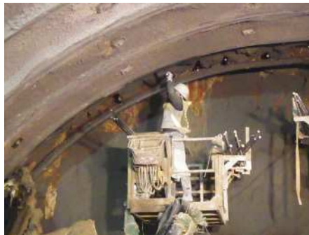
打設（フォアポーリング）
