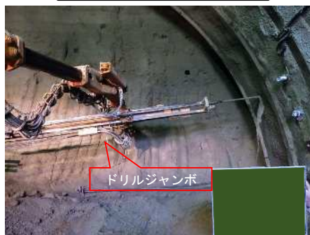
削孔（ロックボルト）
