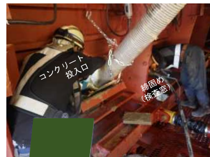
覆工コンクリート（打設）
