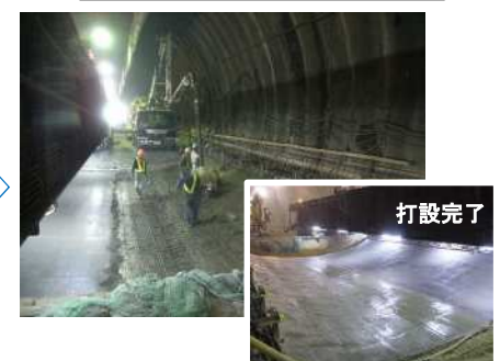
インバートコンクリート打設
