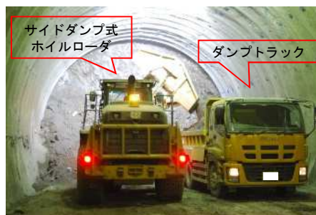
ずり処理（ずり積み込み）
