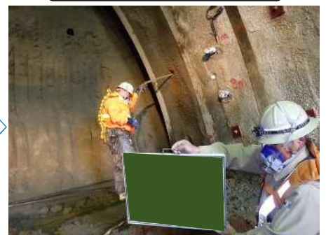
モルタル充填（ロックボルト）
