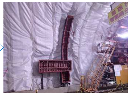
型わく据付(箱抜き型わく)
