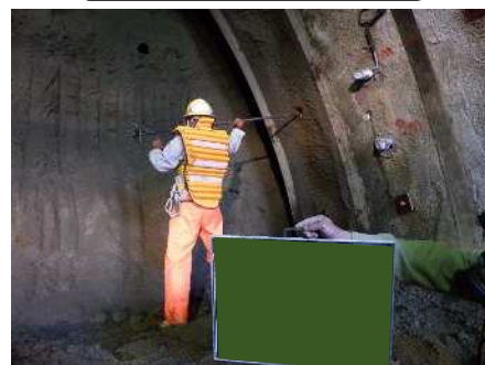
打設（ロックボルト）
