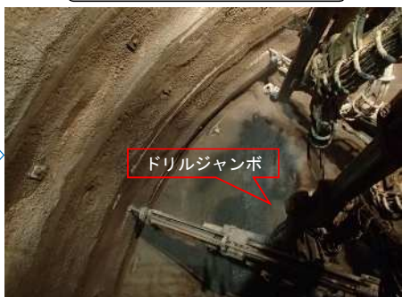
打設（ロックボルト）
