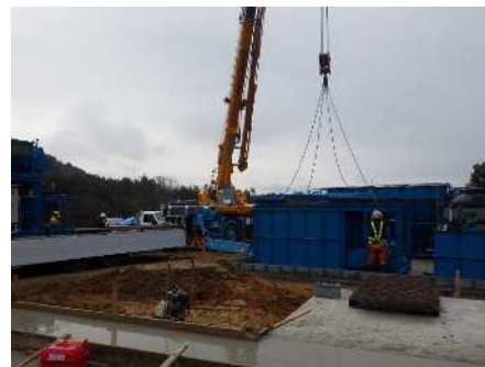
汚濁水処理工（設置状況）
