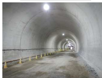
トンネル工完成
