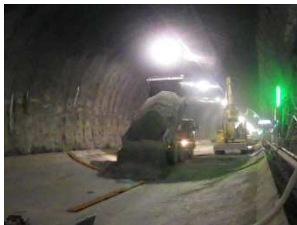
インバート締め完了
