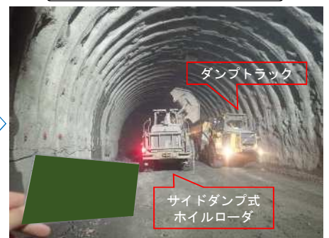
すり処理（すり積み・運搬）
