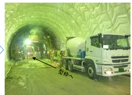
覆工コンクリート（ミキサー車）
