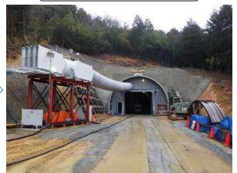
換気設備工（設置完了）
