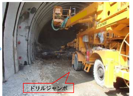
削孔（ロックボルト）
