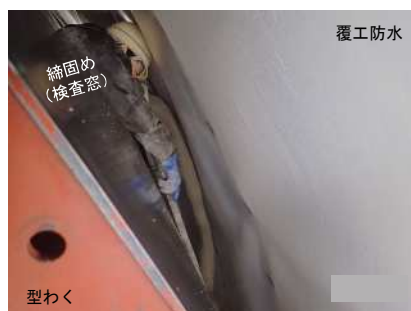
覆工コンクリート（打設）
