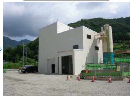
吹付設備工（設置完了）
