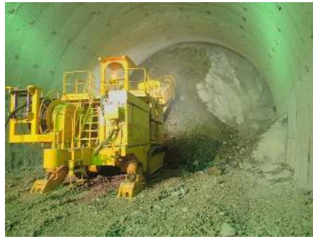
上半掘削（トンネル掘進機）
