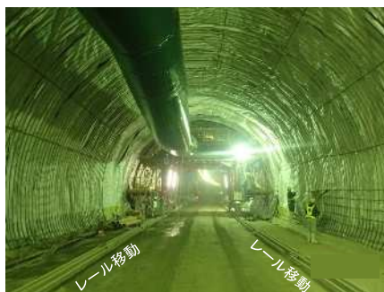
型枠移動（養生完了後）
