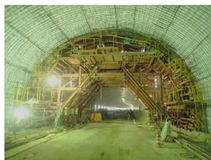
型わく据付完了
