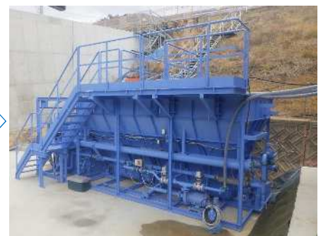
汚濁水処理工（設置完了）
