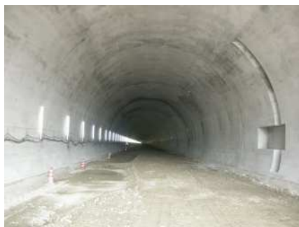
覆工コンクリート打設完了
