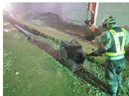
埋戻し材締め
