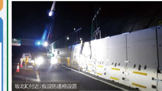
坂北IC(インターチェンジ)～呉ICにおいて、夜間通行止め(11/13～11/29)を実施し、舗装補修工事やトンネル照明更新工事、仮設防護柵設置工事等の作業を行いました。通行止め時は、う回路をご利用いただくなど、工事へのご理解とご協力をいただきありがとうございます。
