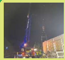
夜間工事の様子
