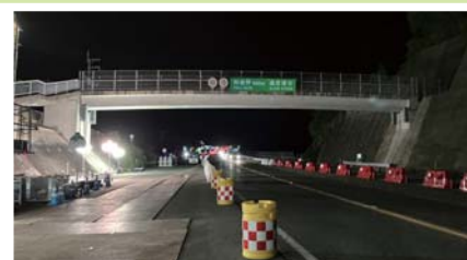
跨道橋撤去前
