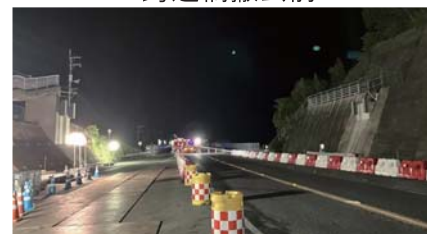
跨道橋撤去後
