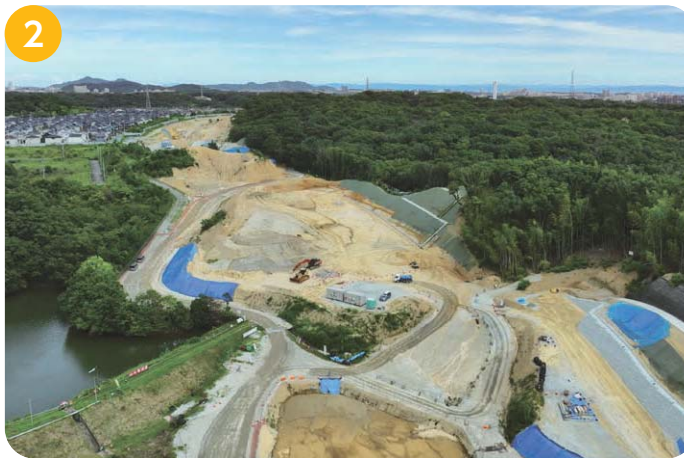
2 樋谷 IC 付近 山を道路の高さまで掘削する工事を行っています。
