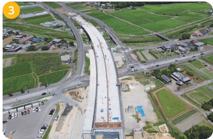
3 菅野交差点付近 県道明石木見線、樋谷川を横架する橋梁工事を行っています。車が走行する床版部分まで工事が完了しました。
