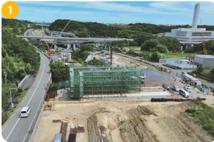
1 永井谷 JCT 付近 橋台、橋脚を構築する工事、山を道路の高さまで掘削する工事を行っています。
