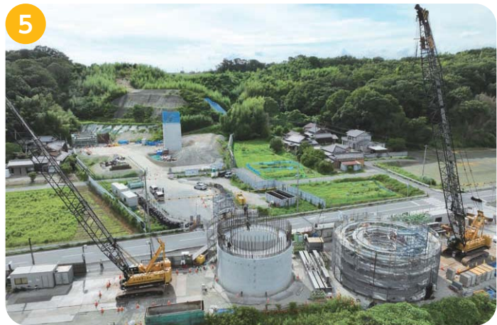
5 石ヶ谷 JCT 付近 平野地区では、橋台、橋脚を構築する工事を行っています。
