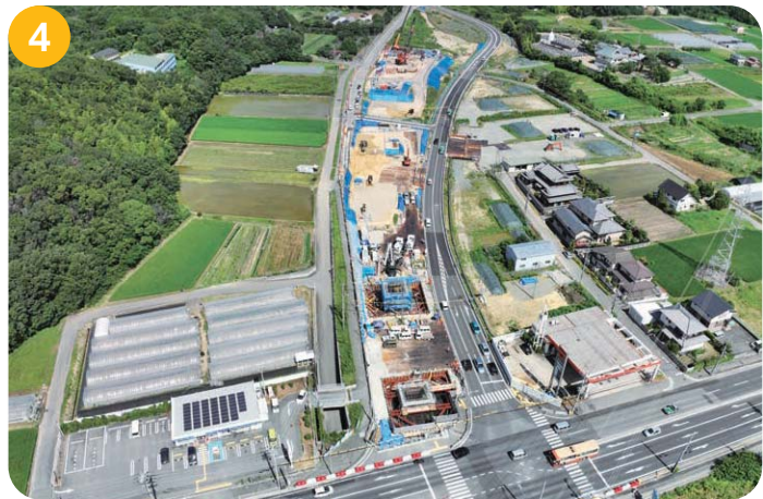
4 下村地区 橋台、橋脚を構築する工事を行っています。
