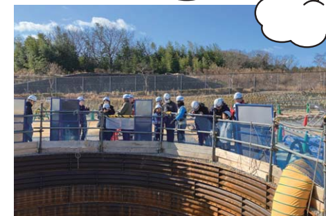
永井谷ジャンクション工事現場見学会 2025.1.25
