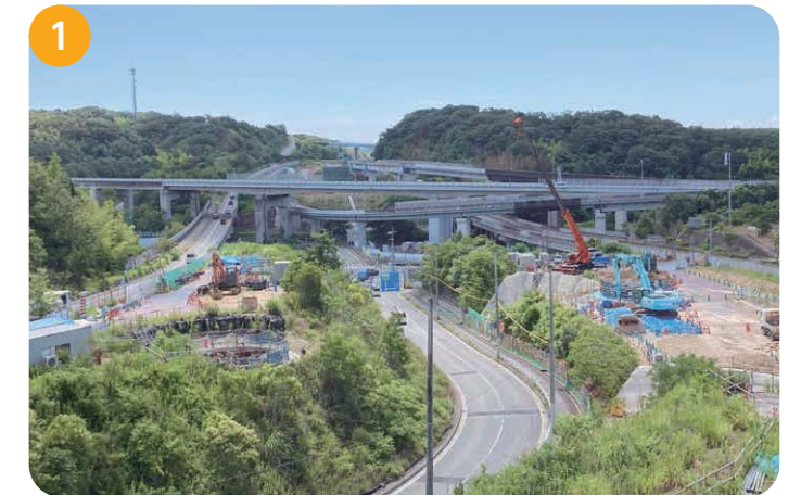
永井谷JCT付近 橋台、橋脚を構築する工事を行っています。
