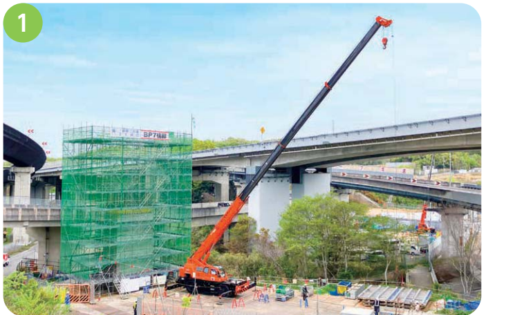
1 永井谷JCT付近 橋台、橋脚を構築する工事を行っています。
