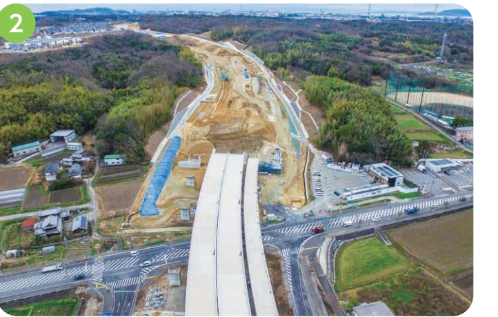
2 櫛谷IC付近 地山を道路の高さまで掘削し、道路を支える擁壁を構築する工事を行っています。
