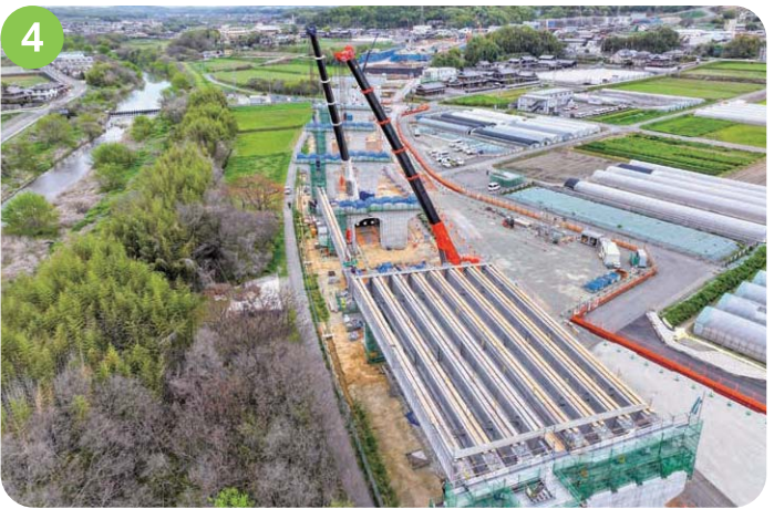
4 平野地区 橋梁を架設する工事を、令和8年より開始しました。また、一部区間で橋脚を構築する工事を行っています。
