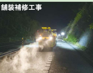
舗装補修工事
