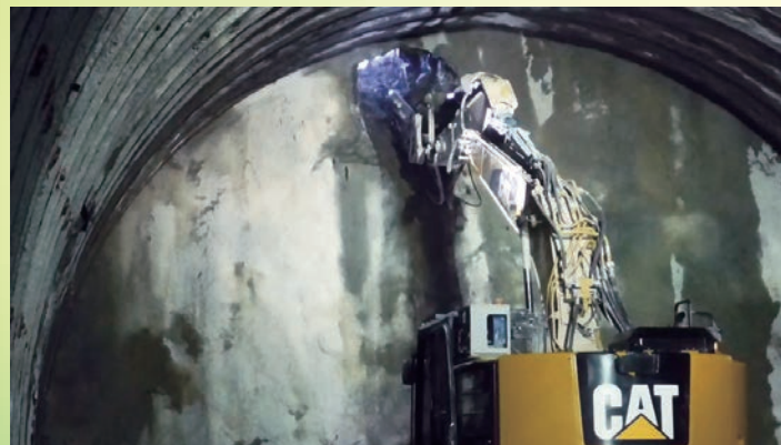
牧トンネル貫通
