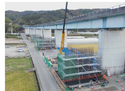
切目川橋(下部工)工事
