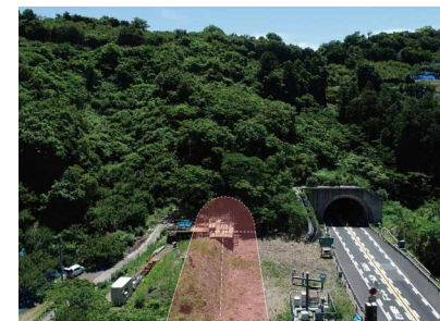
東岩代トンネル他1トンネル工事
