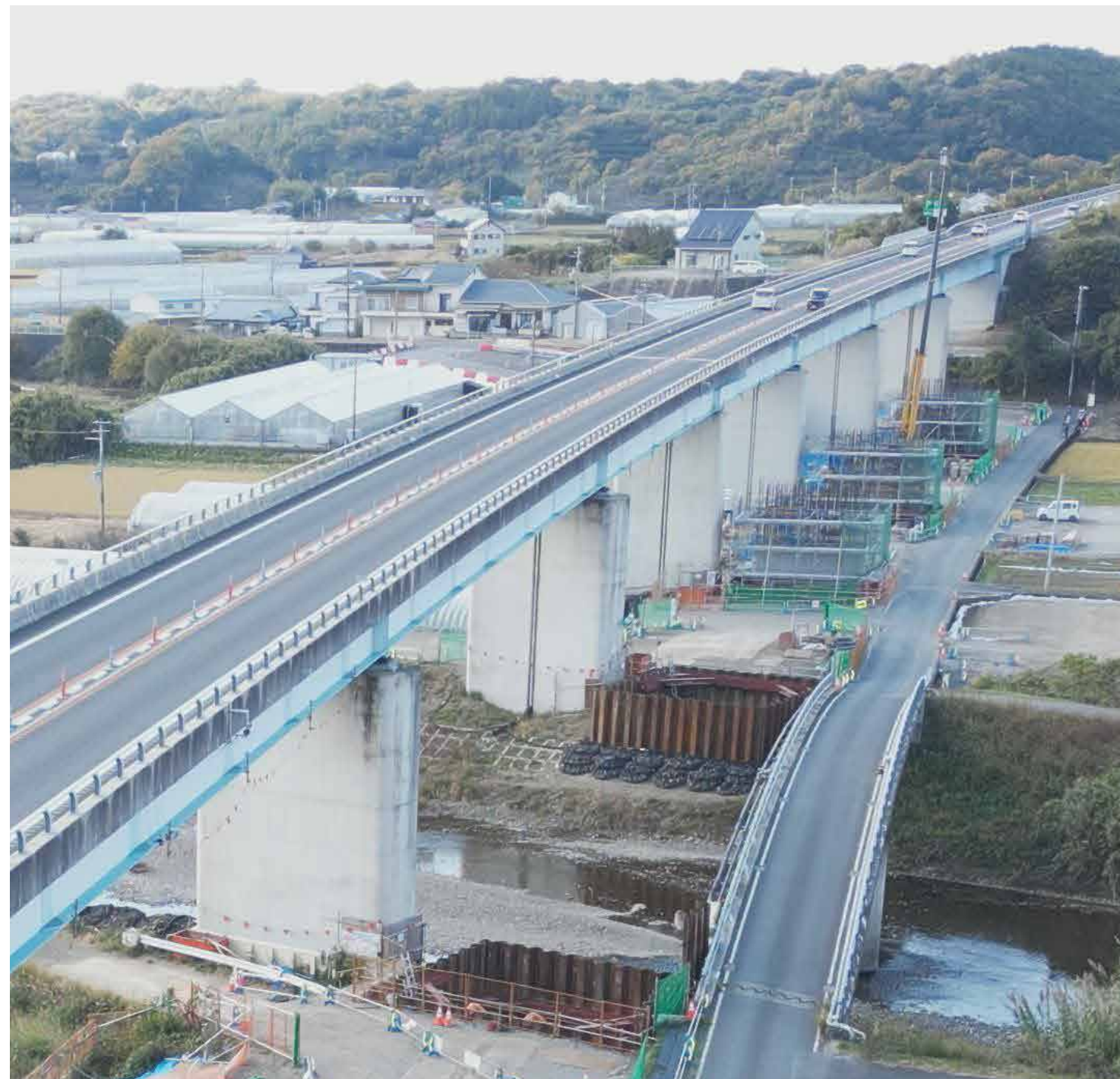
切目川橋(下部工)工事
