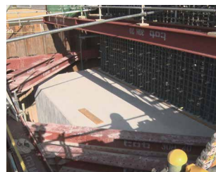
《橋脚下部のフーチング》
