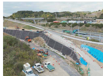
印南西ノ地工事
