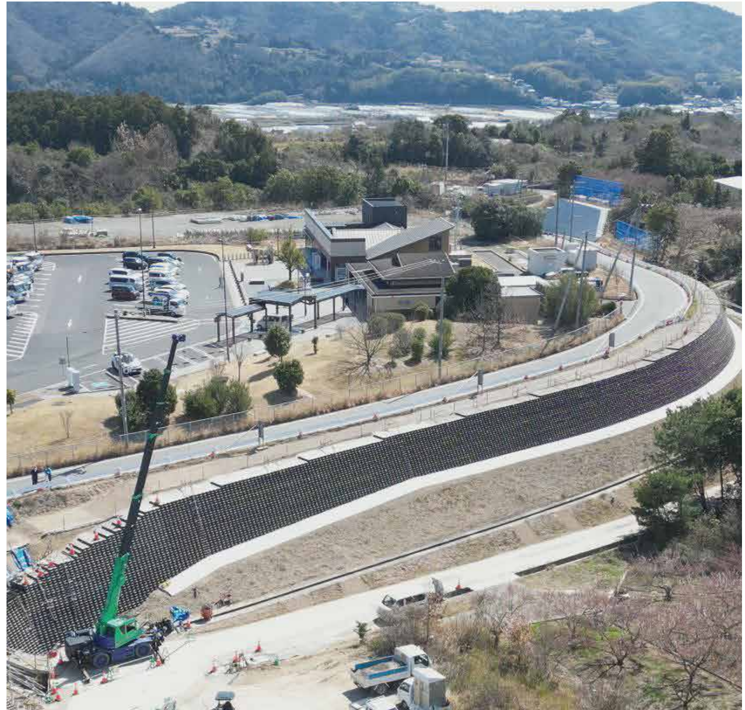
阪和自動車道 印南西ノ地工事 印南SA(上)付近
