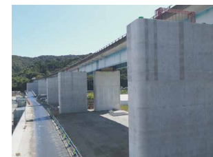
切目川橋(下部工)工事
