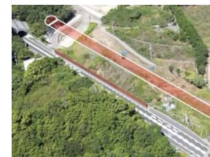
東岩代トンネル他1トンネル工事
