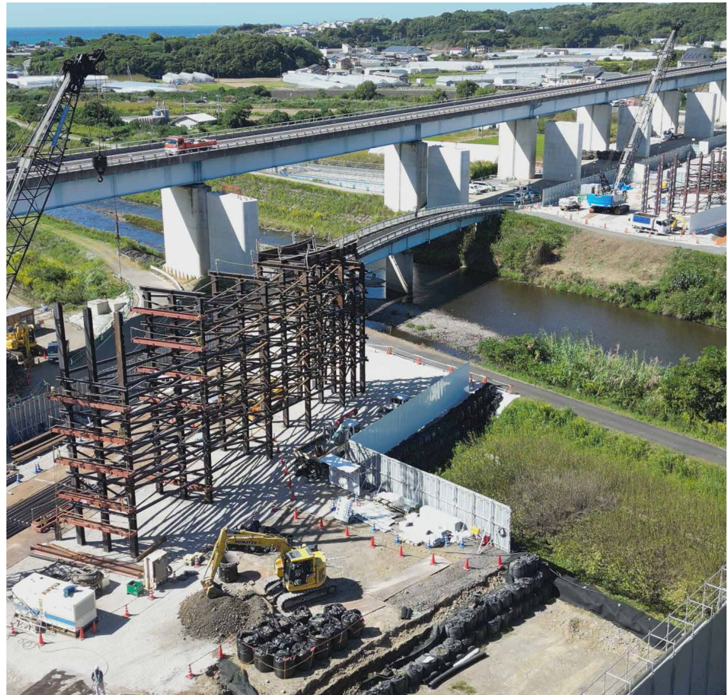
阪和自動車道 島田トンネル工事 仮橋仮設
