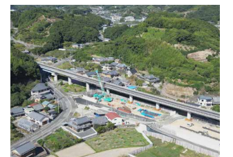
芳養高架橋(下部工)工事
