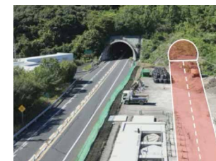
高田山トンネル工事
