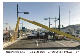
衝突事故により損傷した高さ制限ガード
