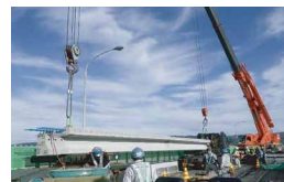
新しい床版の設置
