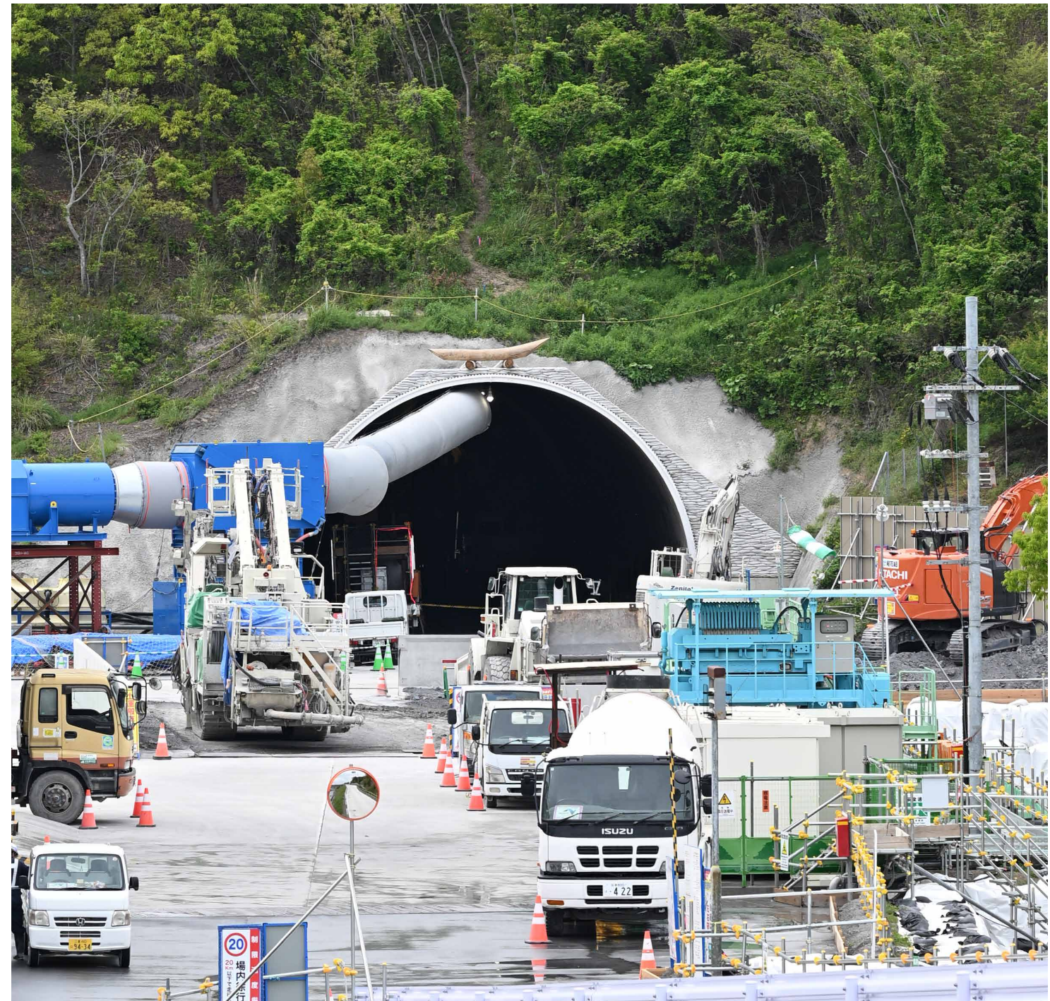
阪和自動車道 高田山トンネル工事 南側坑口
