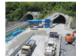
高田山トンネル工事 トンネル本体の掘削作業を実施中
