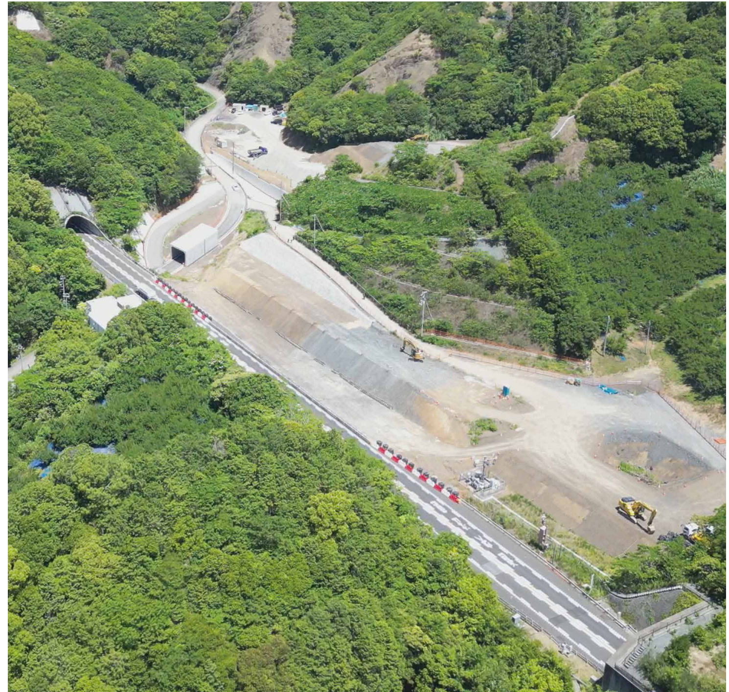
阪和自動車道 西岩代トンネル～東岩代トンネル
