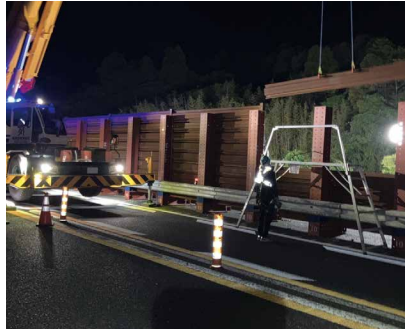
仮設落石防護柵の設置
