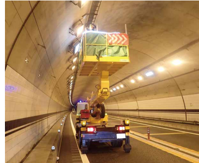
トンネル照明点検
