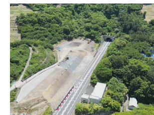
東岩代トンネル他1トンネル工事 トンネル周辺の整備を実施中
