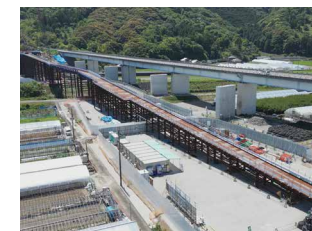
島田トンネル工事 トンネル周辺の整備を実施中
