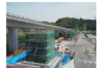
芳養高架橋(下部工)工事 橋梁の基礎のとなる杭及び柱になる部分を施工中
