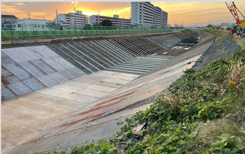
鉄樋設置状況
