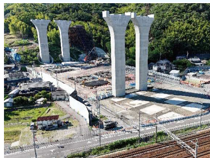
④ ベント基礎及び下部工施工のための準備工（インクライン）の施工を行っております。
