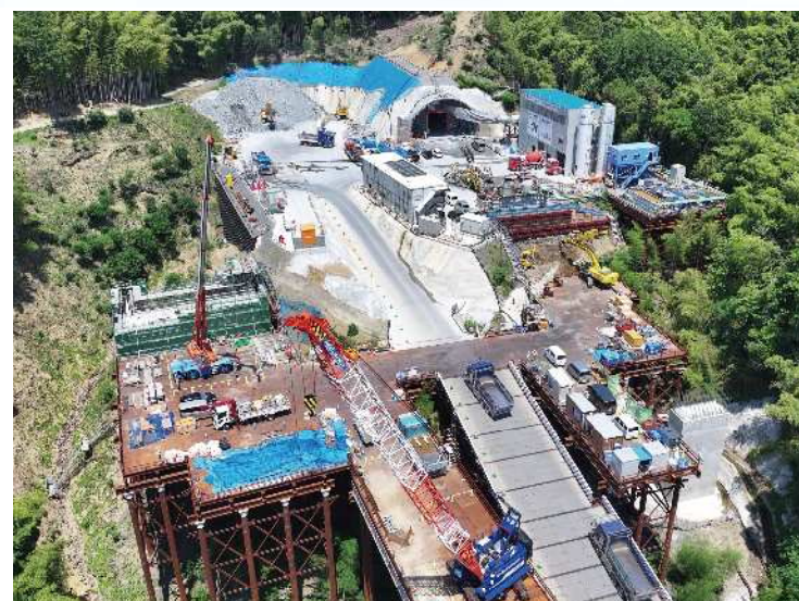
③ トンネル掘削及び橋梁下部工の施工を行っております。
