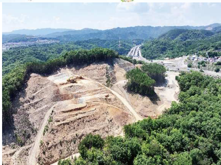
① 土工部の施工を行っております。
