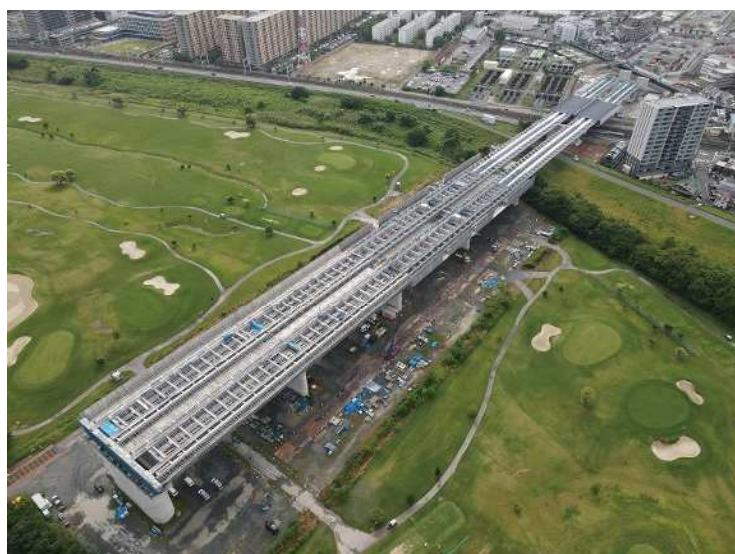
⑥ 橋梁上部工の施工を行っております。
