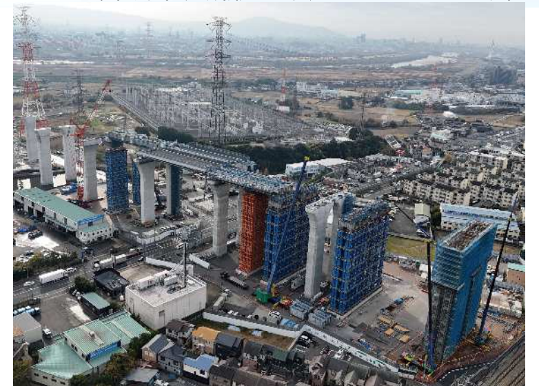
④ 橋梁上部工の施工を行っております。
