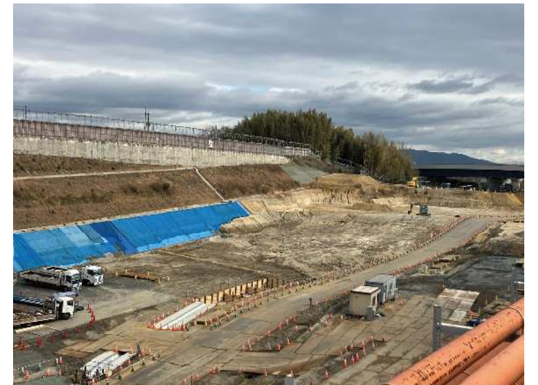
⑧ 掘削の施工を行っております。
