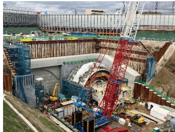
⑦ トンネル掘削のための準備工の施工を行っております。
