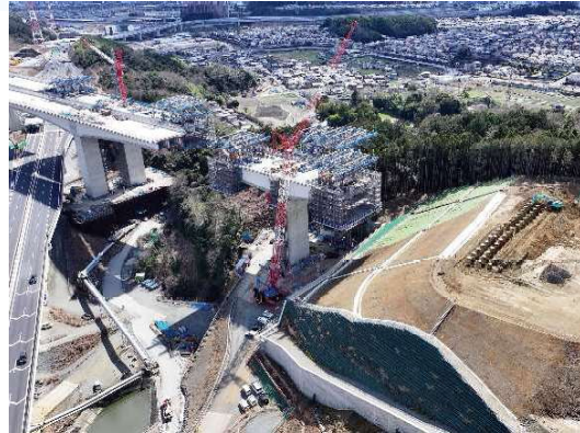
② 橋梁上部工及び橋台の施工を行っています。
