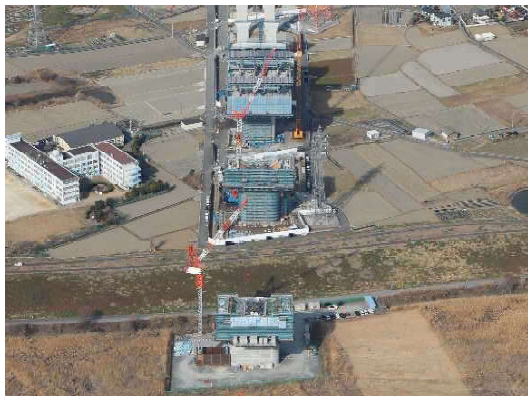
⑤ 橋梁上部工の施工を行っています。
