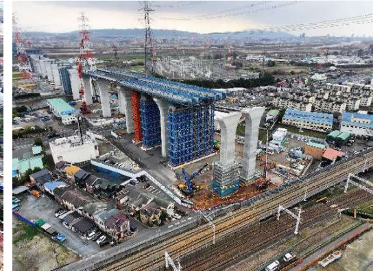
④ 橋梁上部工の施工を行っています。
