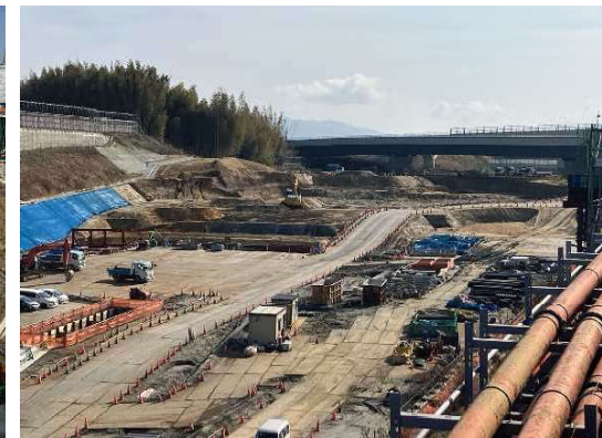
⑧ 掘削の施工を行っています。
