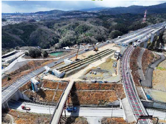
① 橋梁上部工の送出し架設に向けた準備を行っています。
