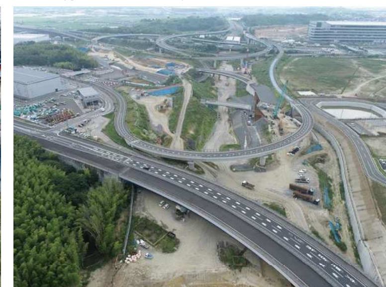
⑧ 八幡京田辺 JCT・IC 土工部の施工を行っております。
