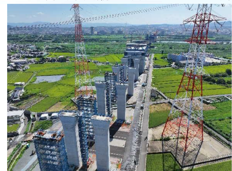
④ 橋梁上部工のための仮設備（ベント）の施工を行っております。
