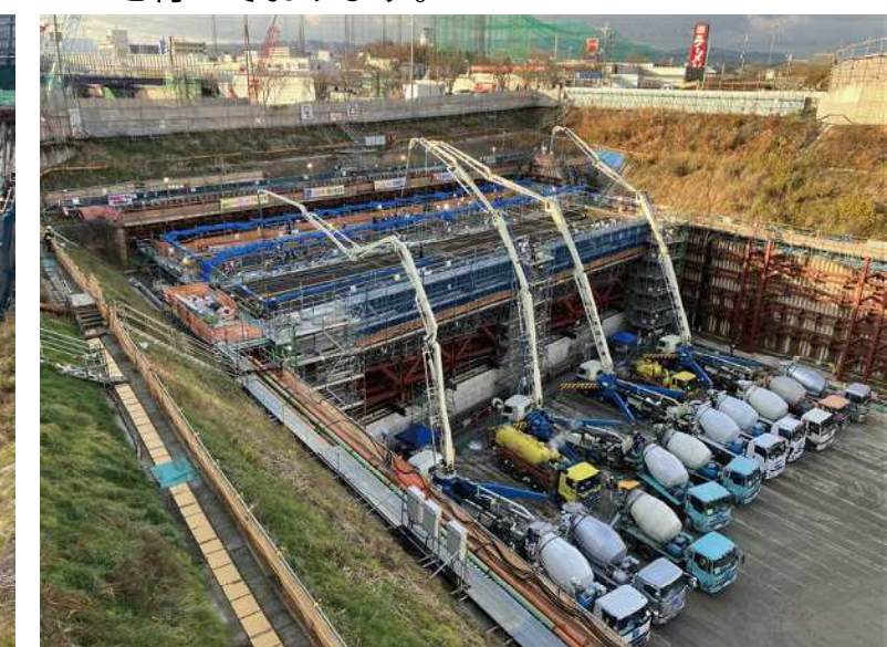
⑧ 推進 BOX の施工を行っております。
