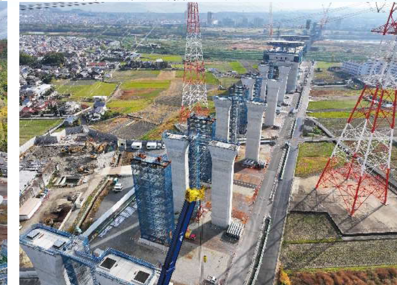
④ 橋梁上部工のための仮設備（ベント）の施工を行っております。
