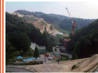
府道余野茨木線に近いところから順次、佐保川橋の橋脚（P3橋脚高さ約70m）の施工を実施しています。
