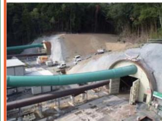
箕面トンネル東坑口よりトンネルの掘削作業を実施しています。
