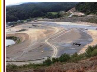
高槻碎石跡地で高盛土箇所の地盤対策工事や調整池等の工事を実施しています。
