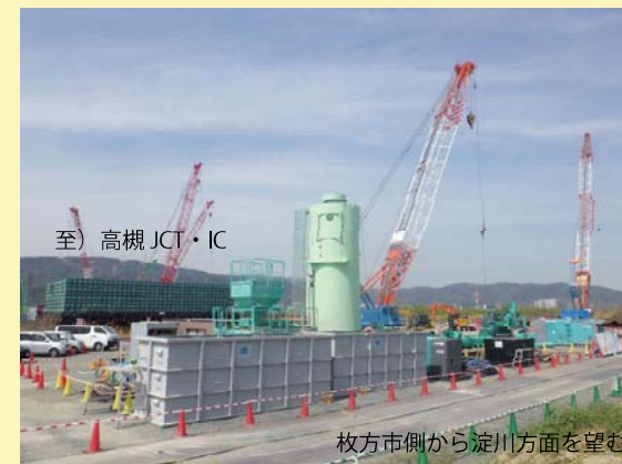
② 淀川両岸で橋脚の基礎となる部分の施工を行っています。
