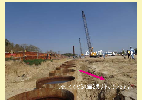
⑥ 八幡市域で土留め用鋼管の打設を開始し、新名神の道路の高さまで地面を掘り下げていっています。
