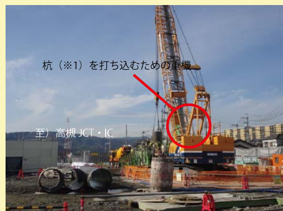
④ 京阪電車沿線で橋脚の基礎となる部分の施工を行っています。
