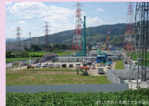
③・④ 橋脚を支える土台部分である杭の施工を行っています。
