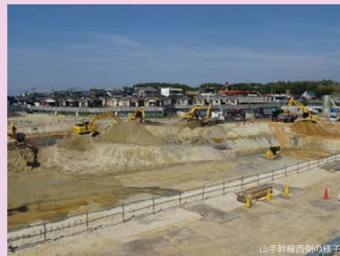
⑥（左）シールドマシン（トンネル掘削機）の発進立坑施工のために地中連続壁で土留めを行っています。（右）山手幹線西側で新名神の道路高さまで地面の掘り下げを行っています。
