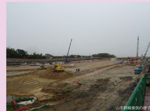
⑦ 八幡市域で新名神の道路高さまで地面の掘り下げを行っています。
