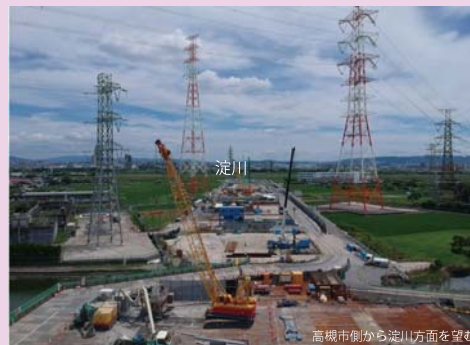
③・④ 橋脚を支える土台部分である杭の施工を行っています。
