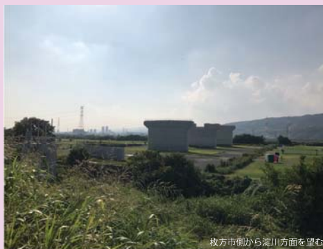
⑤ 橋脚下部工の施工を進めています。
