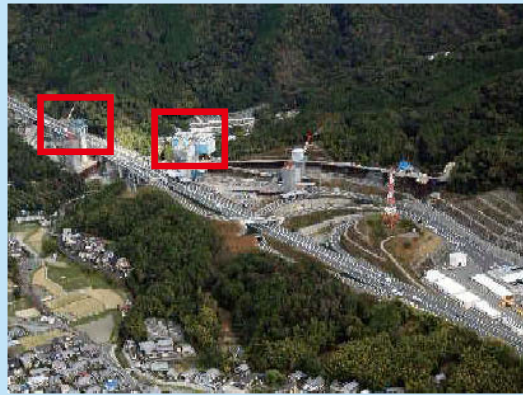
① 赤杭箇所において橋梁上部工の張出架設を行っております。
