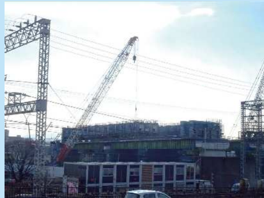
⑥ 橋梁上部工の施工を実施しております。
