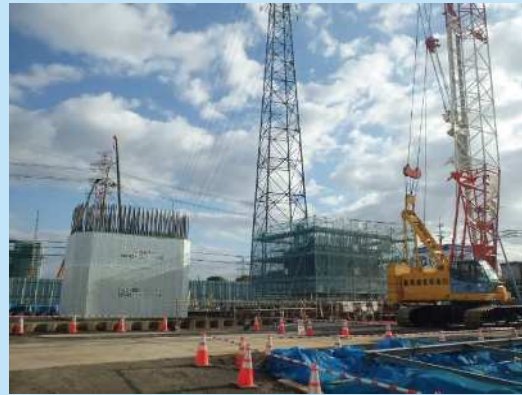
② 橋梁下部工の施工を行っております。
