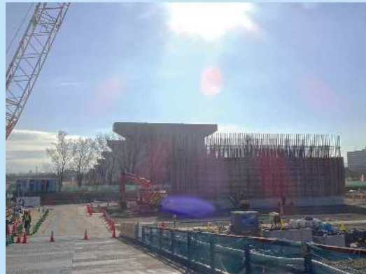
⑤ 橋脚の施工を実施しております。
