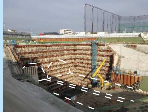
⑦ トンネル発進到達立坑の掘削が完了しました。今後、構造物の施工を進めていきます。
