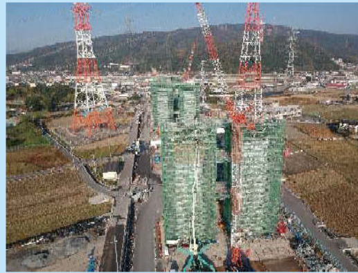
③ 橋梁下部工の施工を行っております。
