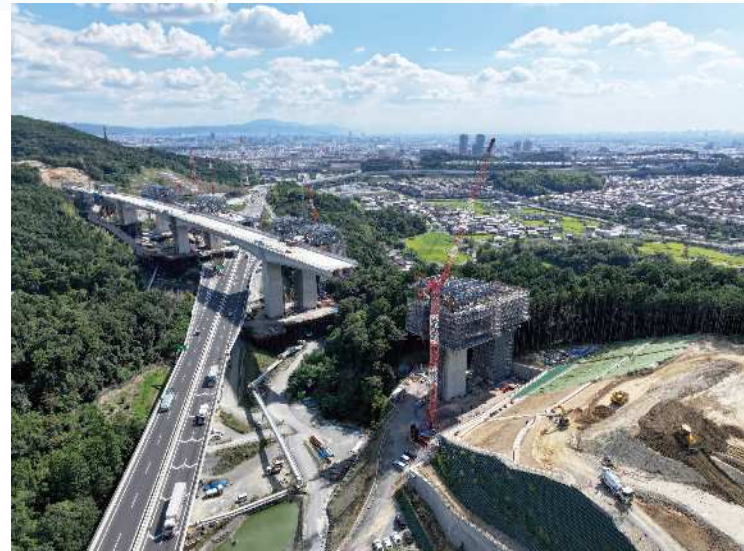
② 橋梁上部工の張出架設及び盛土の施工を行っております。
