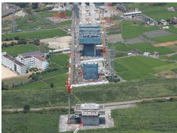
⑤ 橋梁上部工の施工を行っております。
