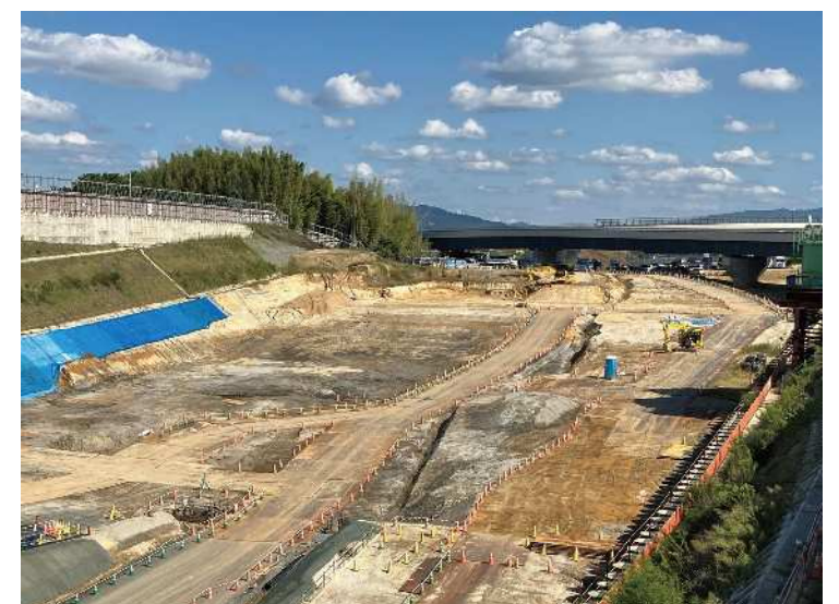
⑧ 掘削の施工を行っております。
