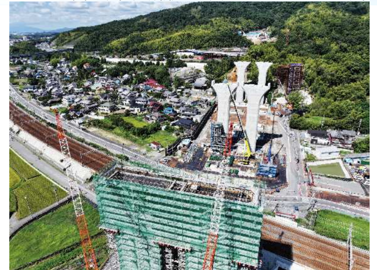
④ 橋梁下部工及びピエントの組み立てを行っております。
