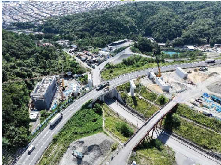
① 橋梁下部工の施工を行っております。
