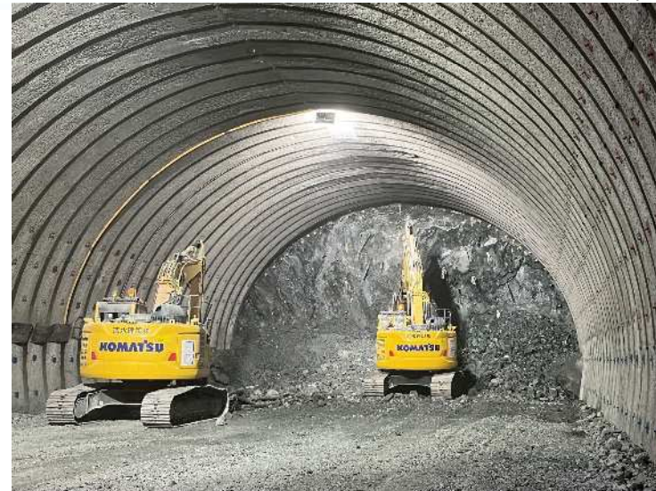
③ トンネル掘削を行っております。
