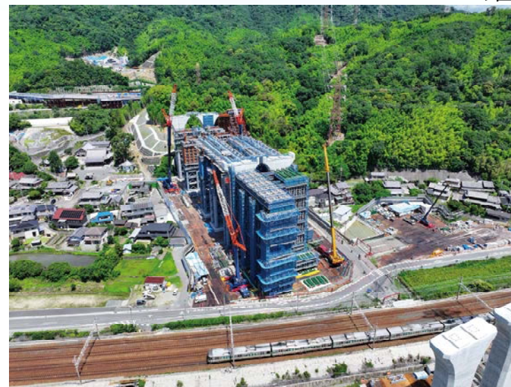
③ 橋梁上部工の施工を行っております。
