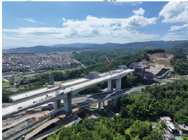
① 橋梁上部工及び橋台の施工を行っております。
