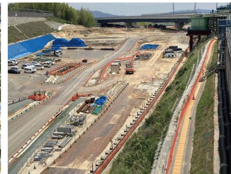
⑧ 掘削の施工を行っております。
