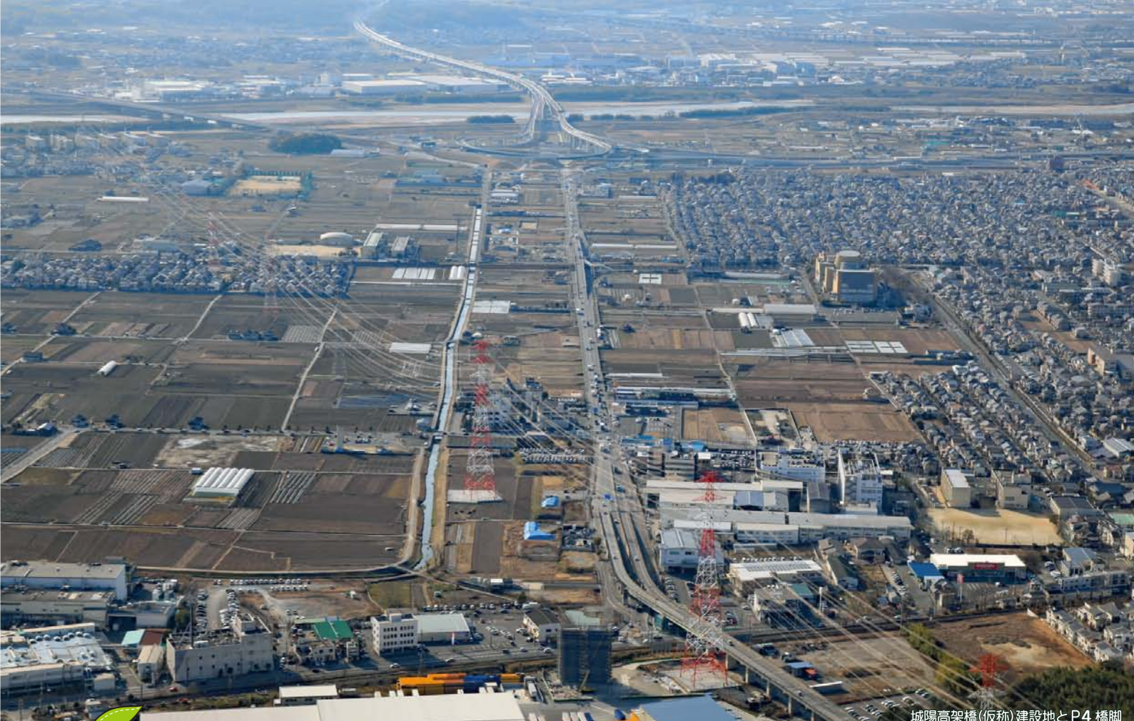
城陽高架橋(仮称)建設地とP4橋脚
