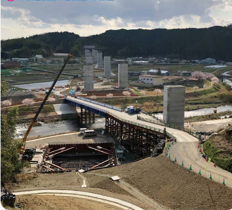
8 宇治田原第二高架橋 下部工
