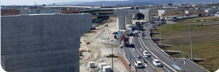
2 城陽高架橋 鋼製門型橋脚
