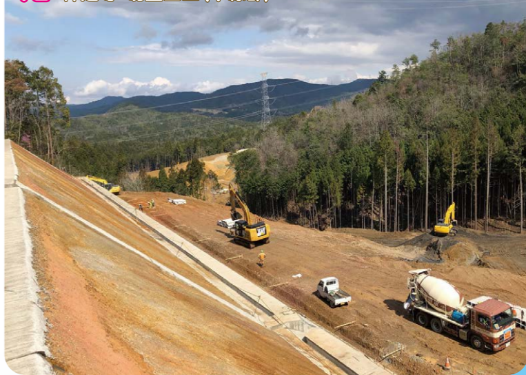
12 禪定寺 切盛土工 (本線部)
