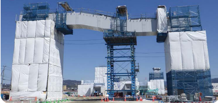
2 城陽高架橋 鋼製門型橋脚
