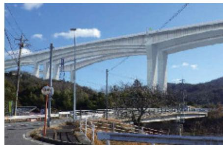
大津JCT(仮)の本線橋である大戸川橋は、全長約1.3kmになる長大橋です。橋梁形式は「波型鋼鉄ウェブ箱桁橋」であり、最長スパン長約160m、最長橋脚高さは75mにもなります。大戸川橋はジャンクション橋であることから、途中
