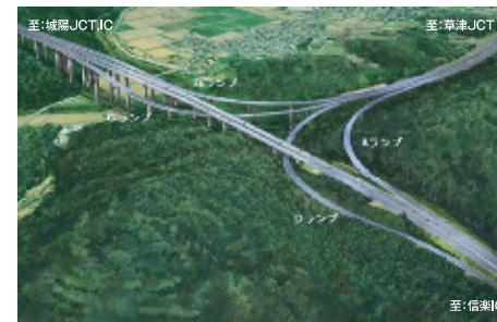
で分岐し、上り線からBランプへ、下り線からCランプへ接続することから全部で4橋が連なる構造になっているのが特徴です。また、大津JCT(仮)の種類は、P9記載の準直結Y型となります。
