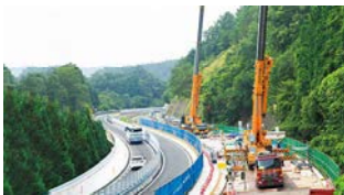
リニューアル工事状況(床版取替)
