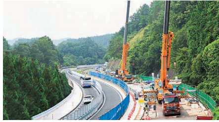
リニューアル工事状況(床版取替)
