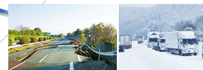
高速道路損傷状況（熊本地震（左）、大雪による立ち往生（右））
