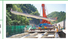
リニューアル工事（床版取替工事）の様子
