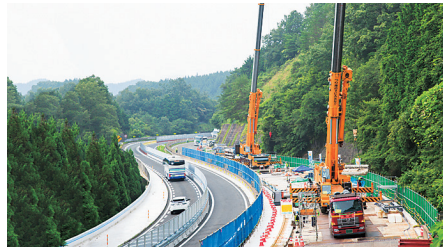
リニューアル工事状況（床版取替）
