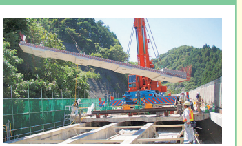
リニューアル工事（床版取替工事）の様子
