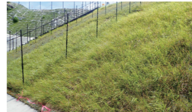
国産在来種による盛土のり面緑化状況
