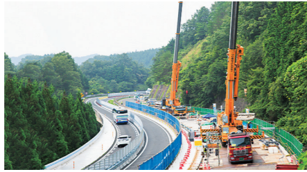
リニューアル工事状況(床版取替)
