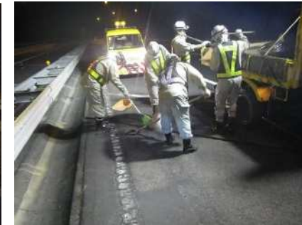
ワイヤロープ設置工事
