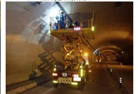
ワイヤロープ設置工事
