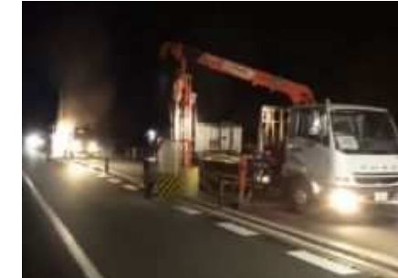
ワイヤロープ設置工事
