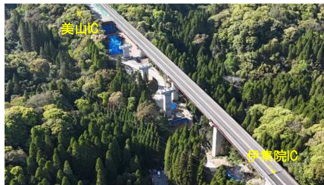
①牧之角橋付近(下部工の様子)
