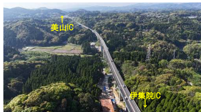
④建設中の橋梁2橋
