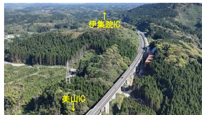
③神之川橋付近(美山IC側より望む)
