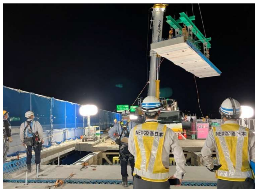
【床板取替工事の様子:新しい床板の設置作業】
