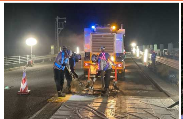
舗装補修工事
