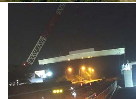
夜間作業実施中 (H29.7)
