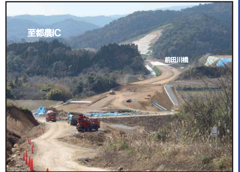
⑦都農町舟川地区土工
