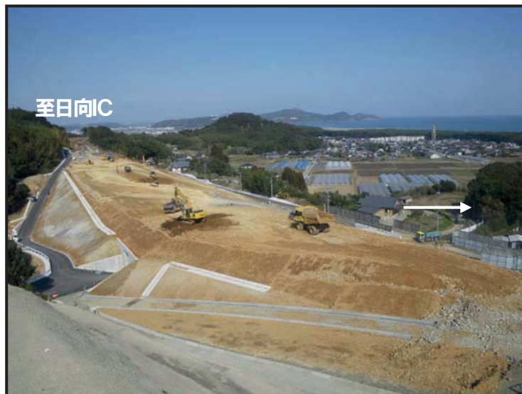
②日向市岡地区土工
