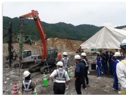
佐伯弥生パーキングエリア(PA)工事
