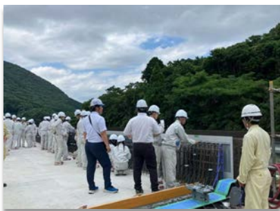
香下大橋他1橋(鋼上部工)工事
