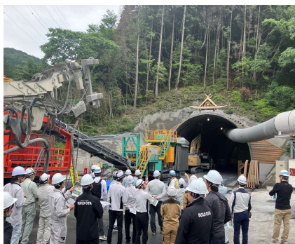
九六位トンネル工事
