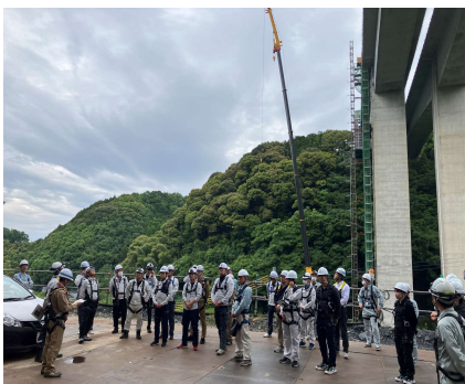
野田橋他1橋(PC上部工)工事
