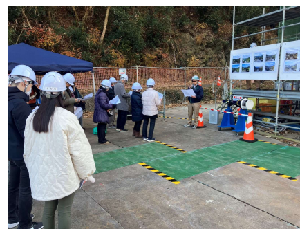
工事概要説明状況
