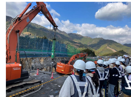
掘削作業の見学状況
