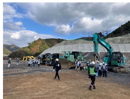
重機の試乗体験状況
