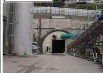
東坑口防音壁
