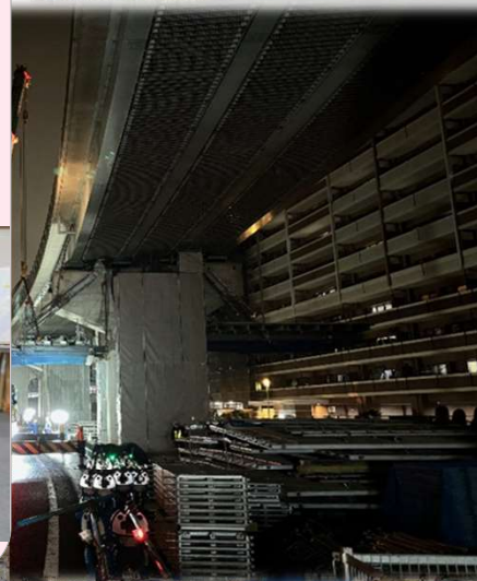
②吊り支保工設置完了
