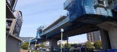
橋桁架設完了
