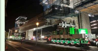
橋桁架設中
