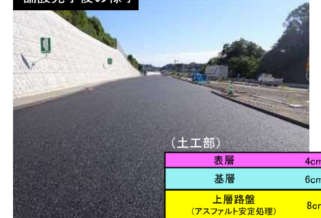
舗設完了後の様子
