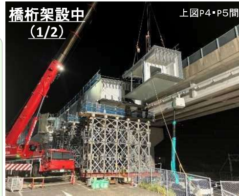
橋桁架設中 (2/2)
