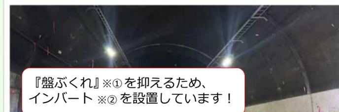
▲インバートコンクリート施工完了
