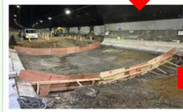
▲インバート型枠組立状況
